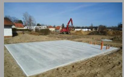
Hause Annel. Die Gründung erfolgt dann auf einer bewehrten Stahlbetonbodenplatte aus wasserundurchlässigem Beton. Die Kelleraußenwände erstellen wir aus hochwärmedämmenden Porenbetonmauerwerk des Herstellers Porit®. Die Innenwände werden ebenfalls massiv gemauert. Die Wanddicken richten sich hierbei ebenfalls nach den statischen Erfordernissen.
